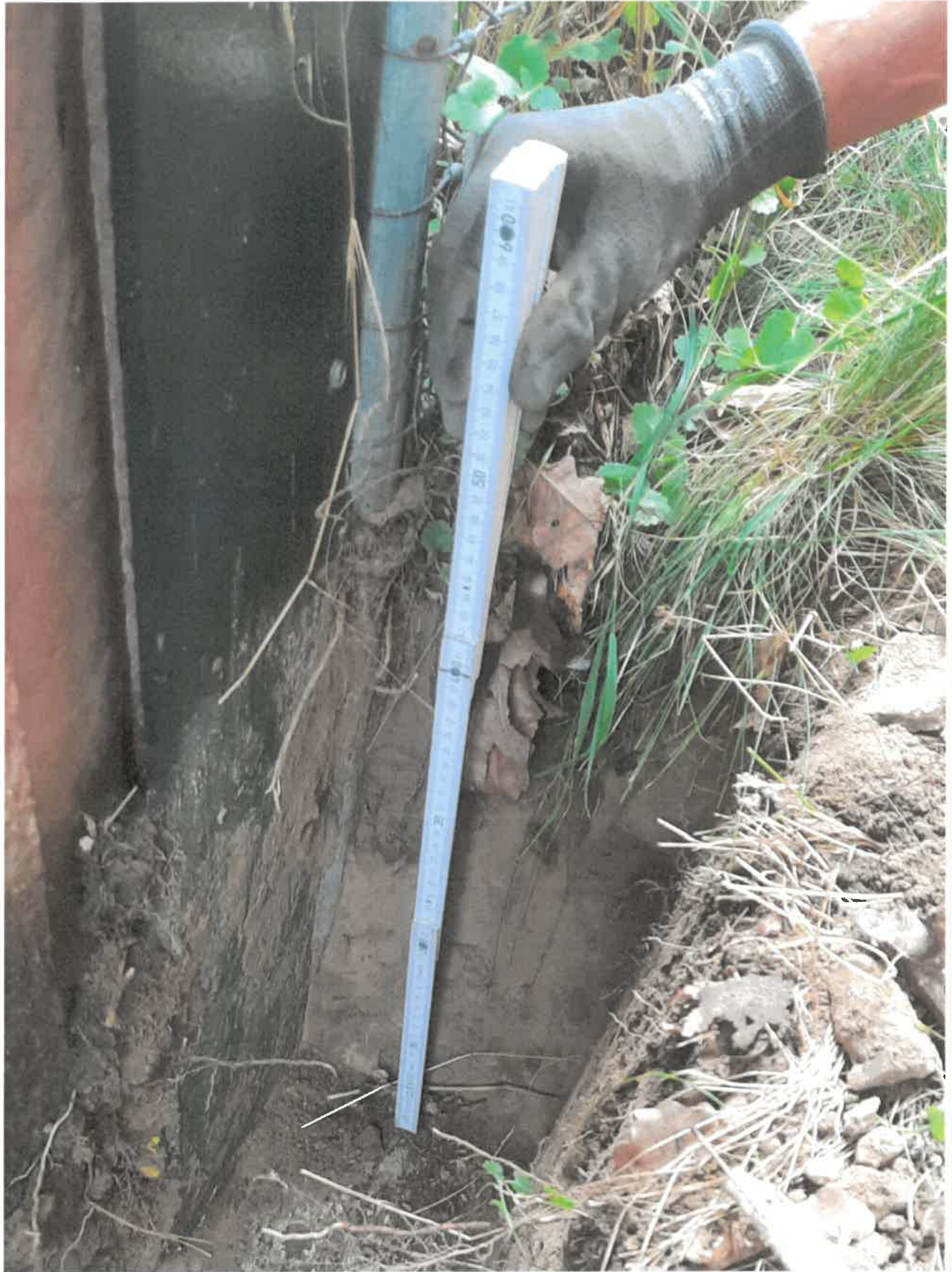
Abb. 1: BW 32Ü-1 Irritationsschutzwand, freigelegter Betonsockel (keine Pfahlköpfe)
