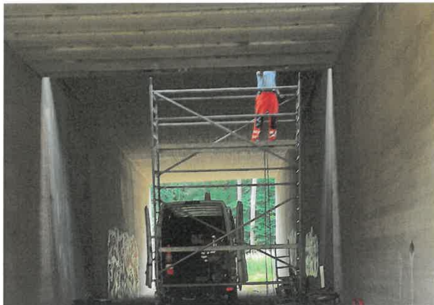
Abb. 1: Bohrkernentnahme Überbau BW32-1, Ansicht am 16.07.2024
